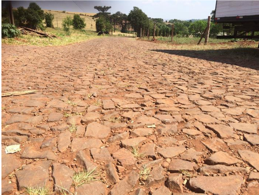
Foto 3 – Detalhe do calçamento com pedras bastantes regulares. Necessidade de preenchimento dos vazios com material granular.
