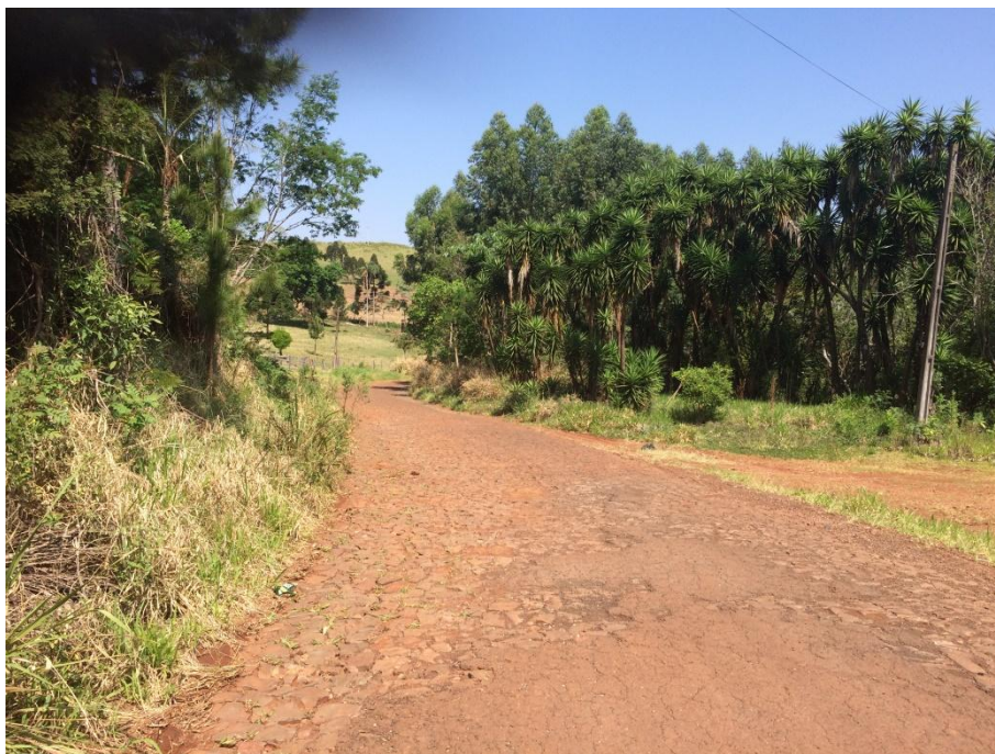
Foto 4 – Vista geral com remendos em CBUQ já apresentando trincamentos e desgaste
