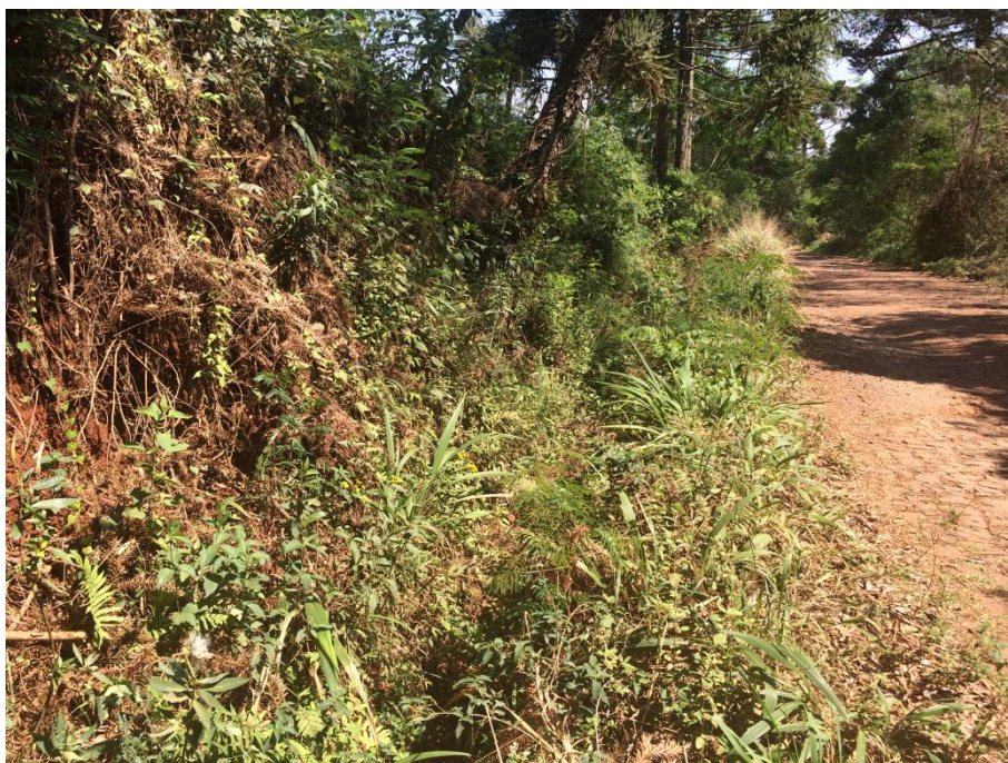
Foto 6 – Necessidade de limpeza e desobstruã de canaleta em toda a extensão
