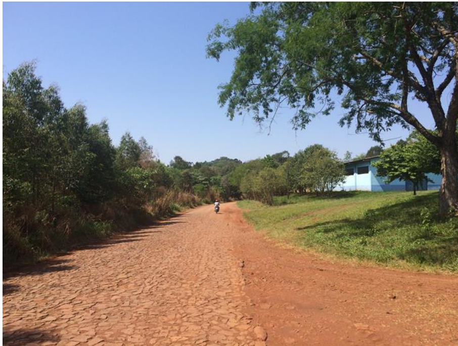
Foto 5 – Vista geral no final do trecho (próximo a Igreja)
