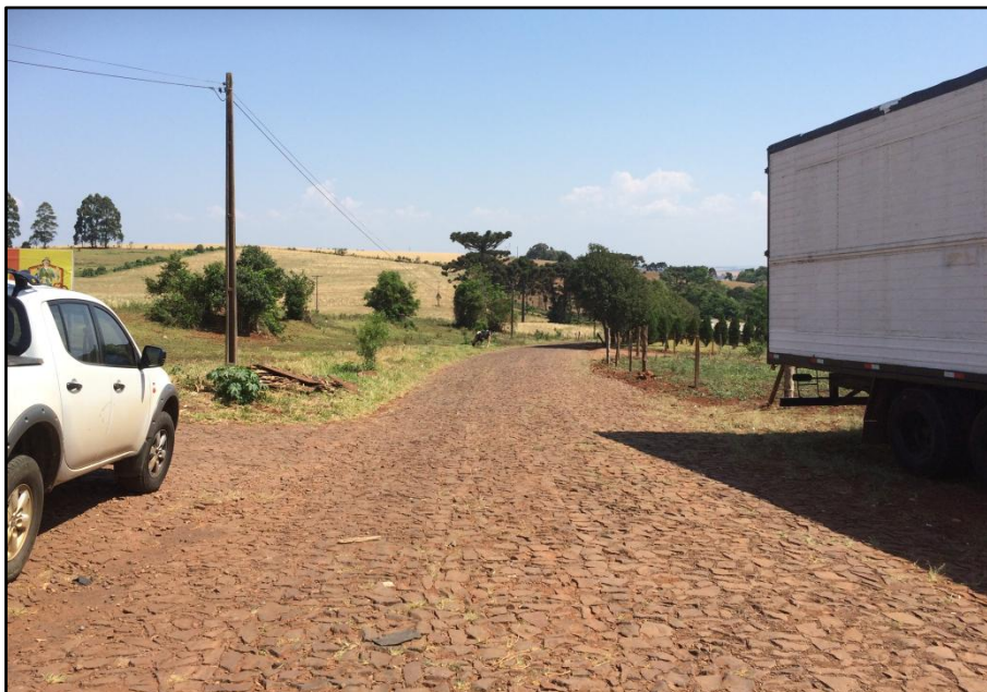
Foto 2 – Início do trecho
