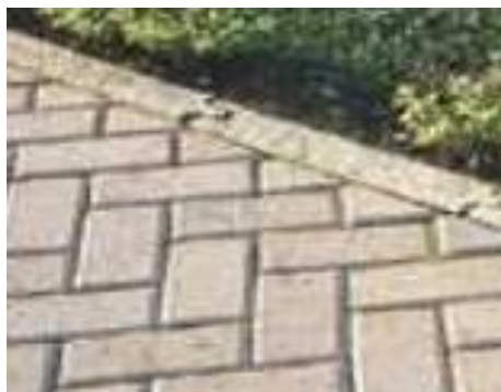
Figura: Guia de Concreto para contenção lateral
