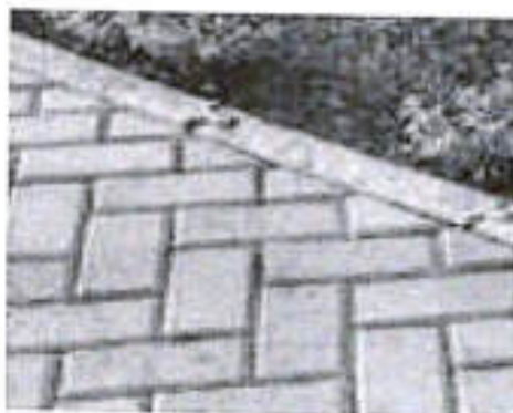
Figura: Guia de Concreto para contenção lateral
