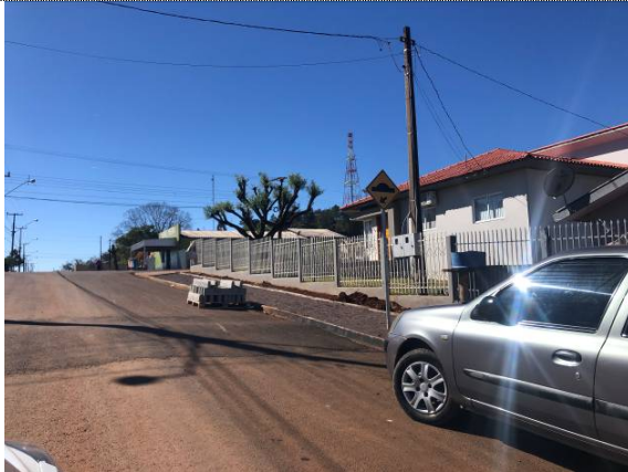
3 – Ondulação e sinalização vertical na Rua Maringá
