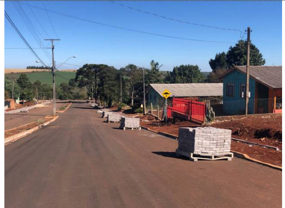
4 – Ondulação e sinalização vertical na Rua Maringá
