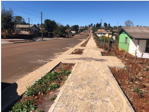
3 – Acesso de veículos com Paver de 6cm
