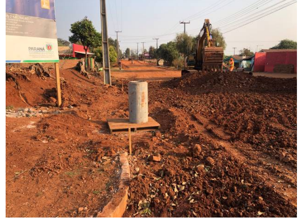
11- Demolição mecânica do pavimento e remoção da camada superficial na Apucarana
