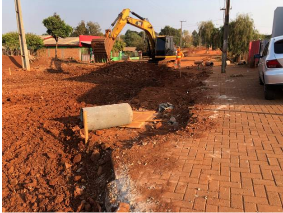
10- Demolição mecânica do pavimento e remoção da camada superficial na Apucarana
