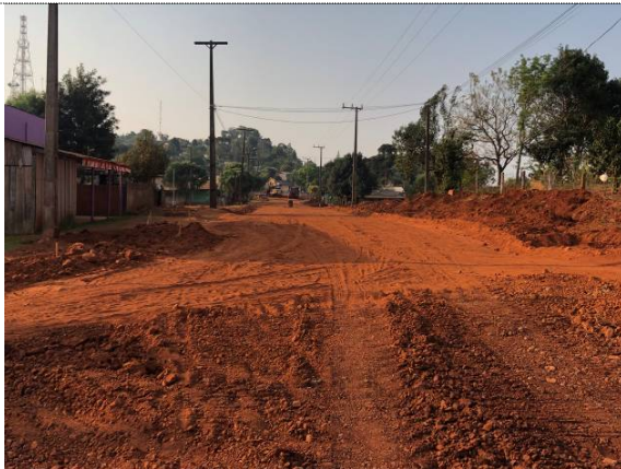
12- Demolição mecânica do pavimento e remoção da camada superficial na Apucarana
