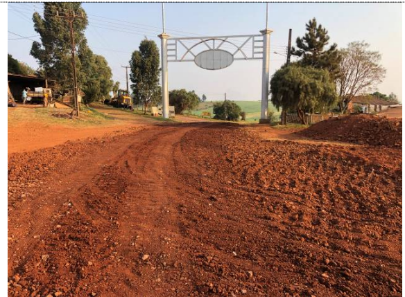
13 - Demolição mecânica do pavimento e remoção da camada superficial na Apucarana
