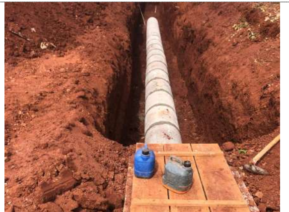
6 – Assentamento de tubos na Rua Goiás
