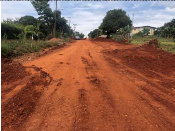
3- Drenagem Rua Goiás
