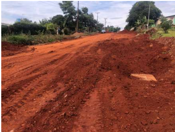
1 – Drenagem Rua Goiás
