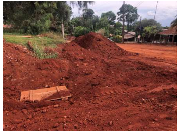
2 – Drenagem Rua Goiás
