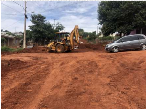
7 - Execução de drenagem
