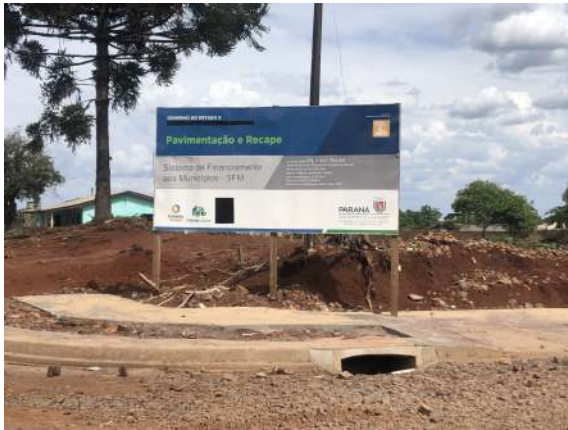
1 - Placa de obra na Rua Apucarana
