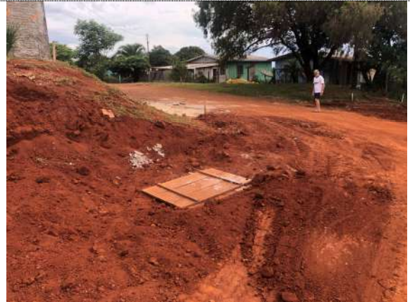
4 – Drenagem Rua Goiás
