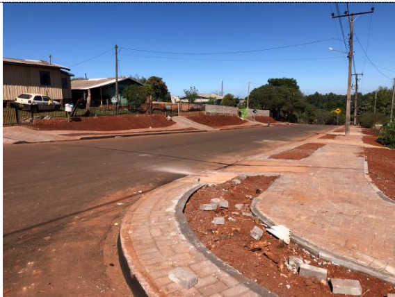
5 – Acesso de veículos com Paver de 6cm
