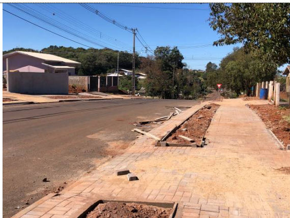
1 – Acesso de veículos com Paver de 6cm
