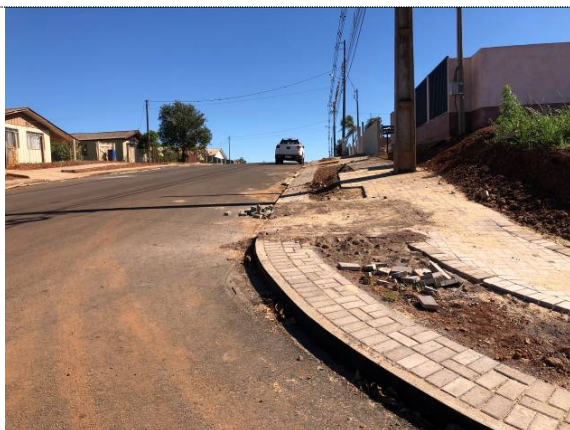
5 – Execução das rampas de acessibilidade
