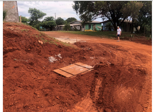
4 – Drenagem Rua Goiás
