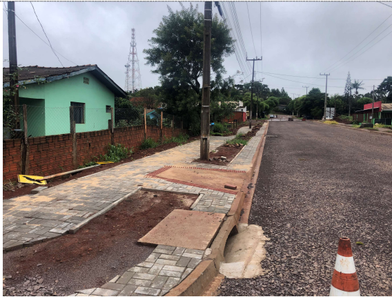
1- Acessibilidade na Rua Apucarana
