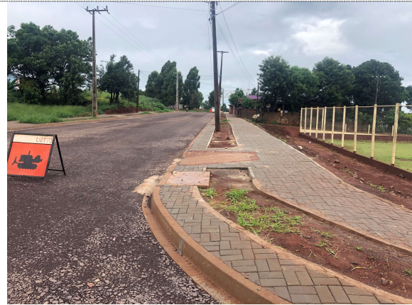
2 - Acessibilidade na Rua Apucarana
