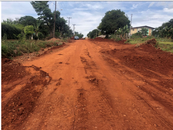
3- Drenagem Rua Goiás
