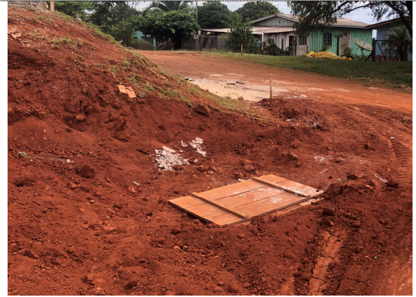
6- Boca de lobo da Rua Goiás
