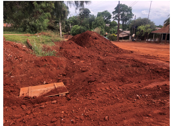
2 – Drenagem Rua Goiás
