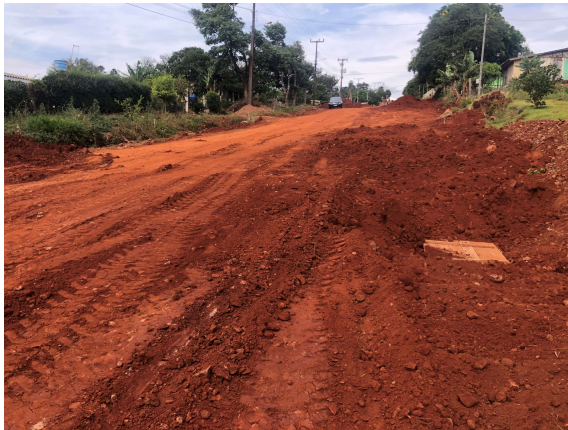
1 – Drenagem Rua Goiás
