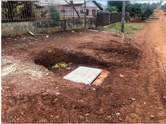
2- BL executada na Rua Pernambuco
