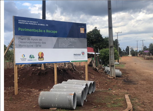
1 - Placa de obra instalada na Rua Apucarana
