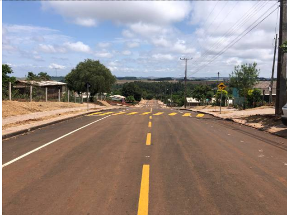
1 – Sinalização horizontal, paver e fincadinha
